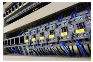
I PLC sono dei computer programmabili utilizzati nelle giostre per gestire molte funzioni. Sia i PLC che i componenti collegati funzionano con una corrente continua di 24 Volt generata da un alimentatore installato nel pannello elettrico e che generalmente accetta entrambe le frequenze.
